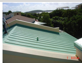
Sarnafil Décor roof view
