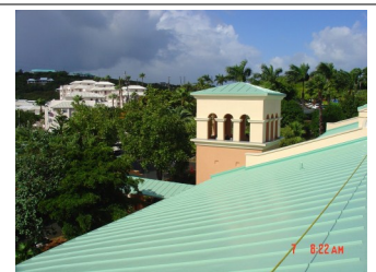
Sarnafil Décor roof view
